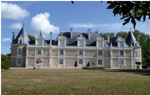
Château de l'Alleu (Pontlevoy) : allée cavalière, jardin et église en cours de restauration
